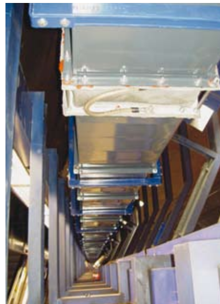
Teilstück der 900 Meter installierten Entrauchungskanäle in der bestehenden Deckenkonstruktion der Perrons.
